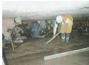
免震床スラブCO 打設
