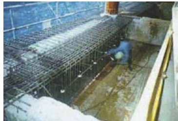
既存基礎貼り補強
