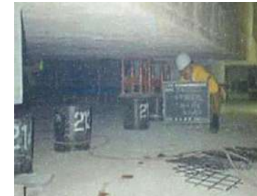
仮受鋼管杭切断撤去
