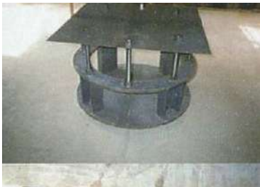
免震装置取付
