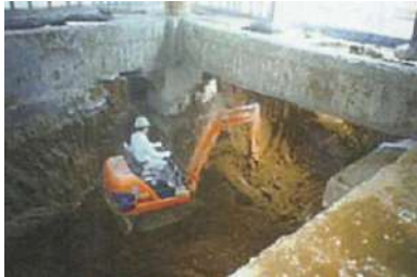
床下・基礎廻り 掘削
