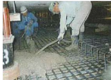
免震床スラブCO 打設
