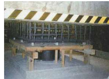
免震装置受け基礎CO打設
