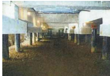
基礎下端 掘削
