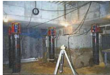
油圧ジャッキで鋼管杭圧入
